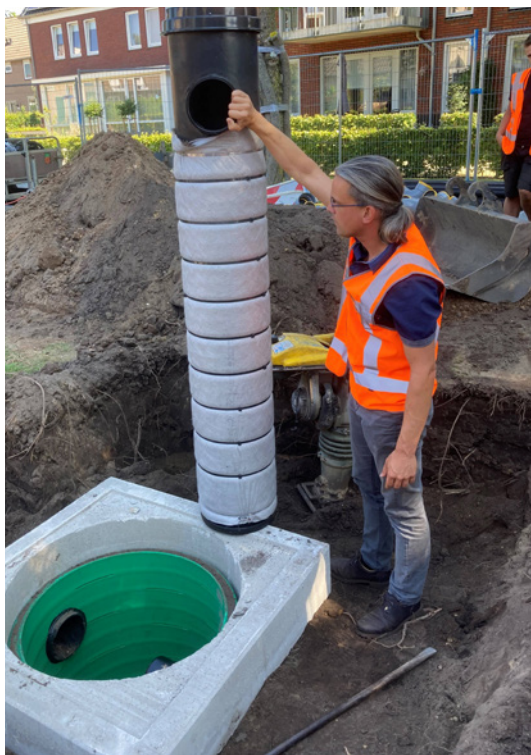
Proeven voor verticale infiltratieputten in het kader van het EU LIFE-project
